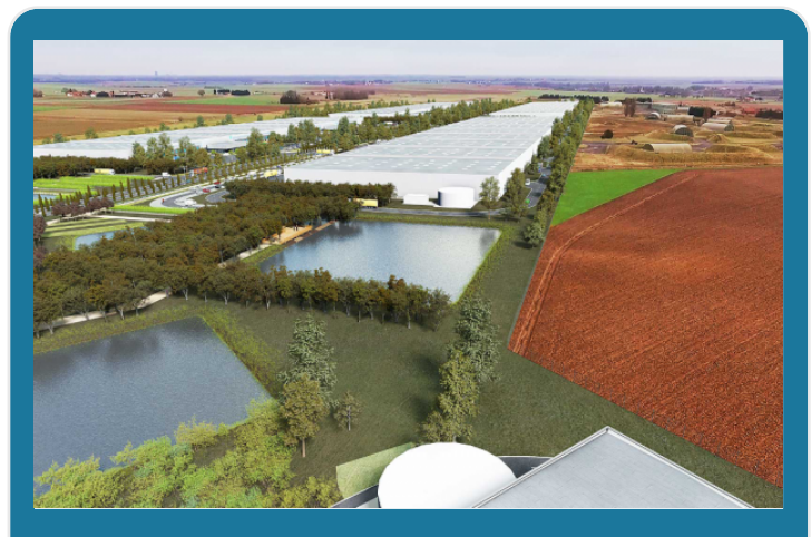
Source : e-valley - projet de livraison par drones
