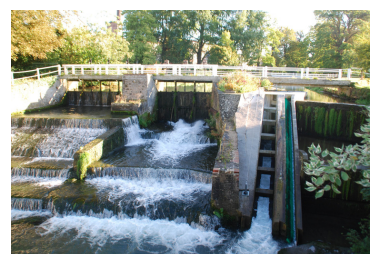
Source : DREAL Hauts-de-France Barrage hydroélectrique
