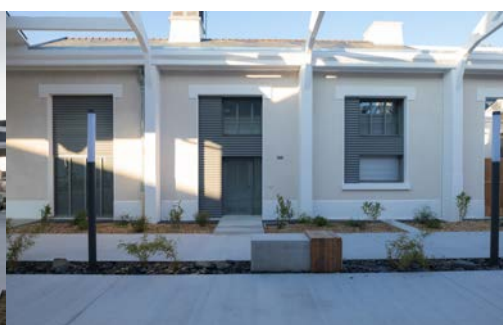
Vue sur un logement.
