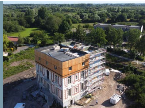
Vue aérienne sur les travaux
