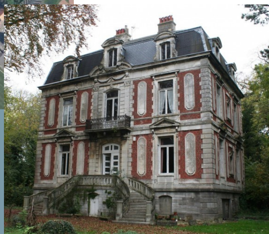
La bâtisse avant travaux, une architecture de qualité
