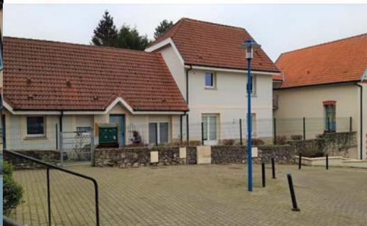
Vue sur les nouveaux logements
