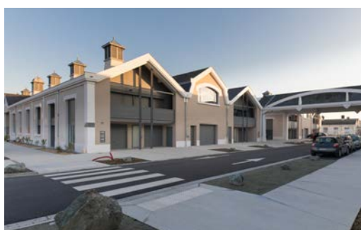
Vue extérieure après travaux.
