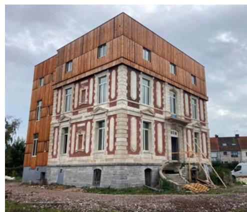
Travaux en cours de réalisation
