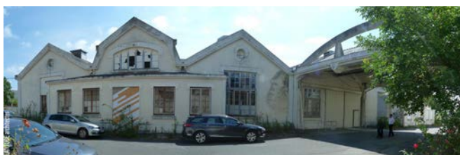
Vues extérieure et intérieure de la friche avant travaux
