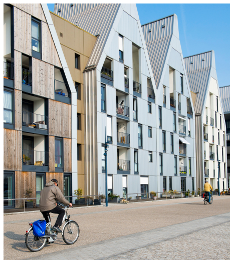
Dunkerque, écoquartier du Grand Large - Jean-Luc CORNU
