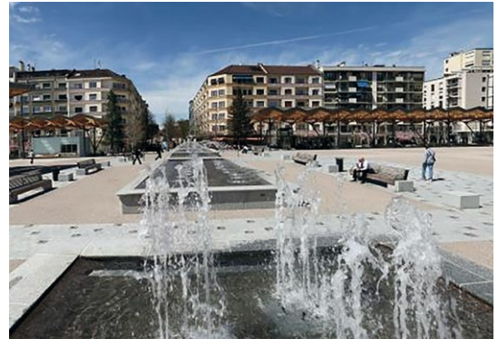
Exemple de réseau de fontaines pour la place Daudré © Production Atelier Fontaine dans le cadre de l'aménagement de place de la Libération d'Annemasse – Photos : Romain Blanchi - Maîtrise d'ouvrage : Commune d'Annemasse – 2011/2016
