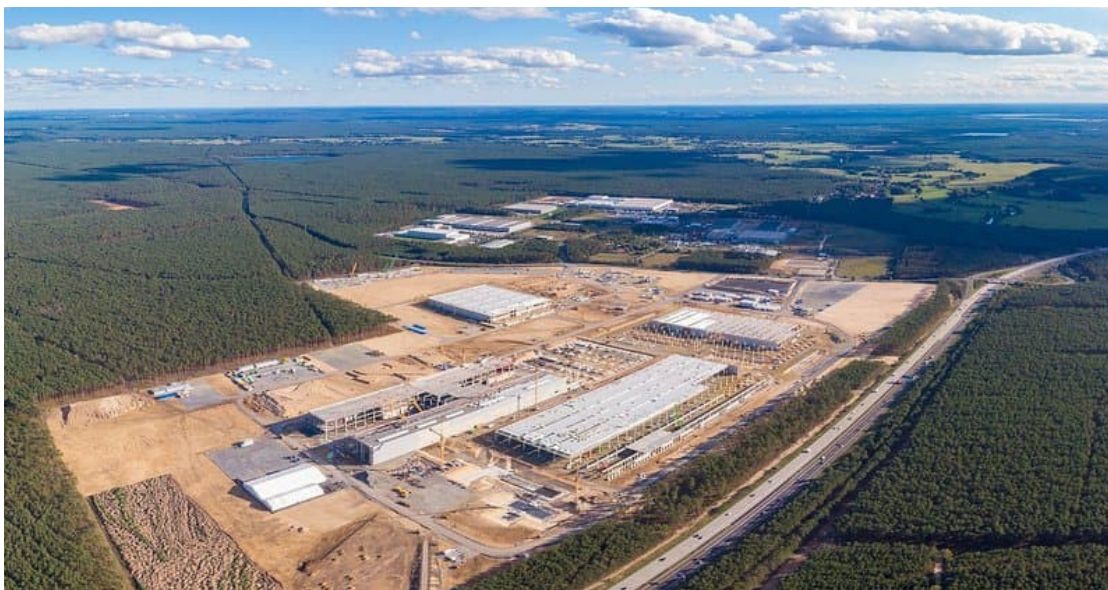
Chantier en cours de l'usine Tesla à proximité de Berlin (Grünheide) : l'objectif de l'entreprise est de commencer à produire en 2021. Les autorisations ne sont pas encore toutes accordées au projet et l'entreprise a dû verser plusieurs cautions.
