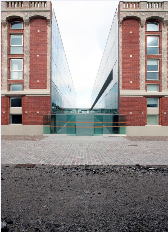
Entrée de la halle aux sucres, Dunkerque, 2014, Inventaire général du patrimoine culturel, Photographie : Pierre Thibaut
